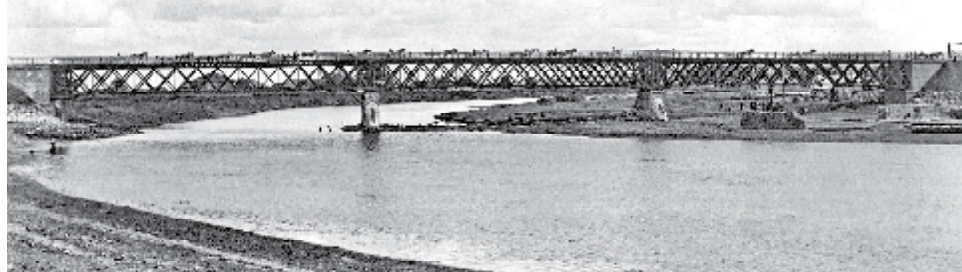
Мост, построенный земством через Обву в 1912 г. Он был разобран по причине ветхости в 1925 году.
